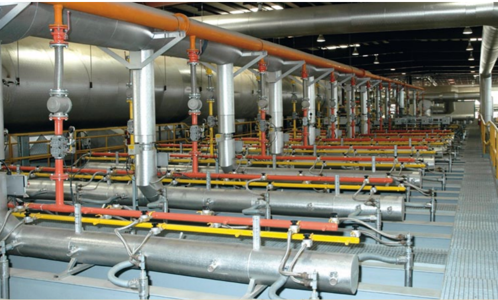
Dualbrennanlage für Biogas und Erdgas Dual fuel firing system for landfill gas and natural gas
